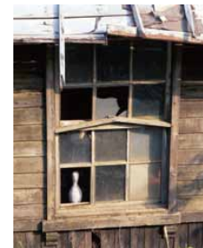
変電所の窓にボーリングのピンが何故有るのかは不明 震災の影響で倒壊してしまった RZ67 II APO350mm F32 1/30 秒
