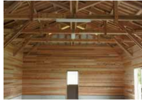
「写真の家」の拘りは、柱無しと高天井です。
