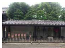
⑱西蓮寺は、付近の廃寺となった地藏院・満願寺・観音寺の本尊と熊野神社のご神体が安置されています。
