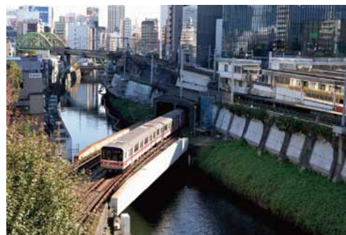
聖橋から見る地下鉄
